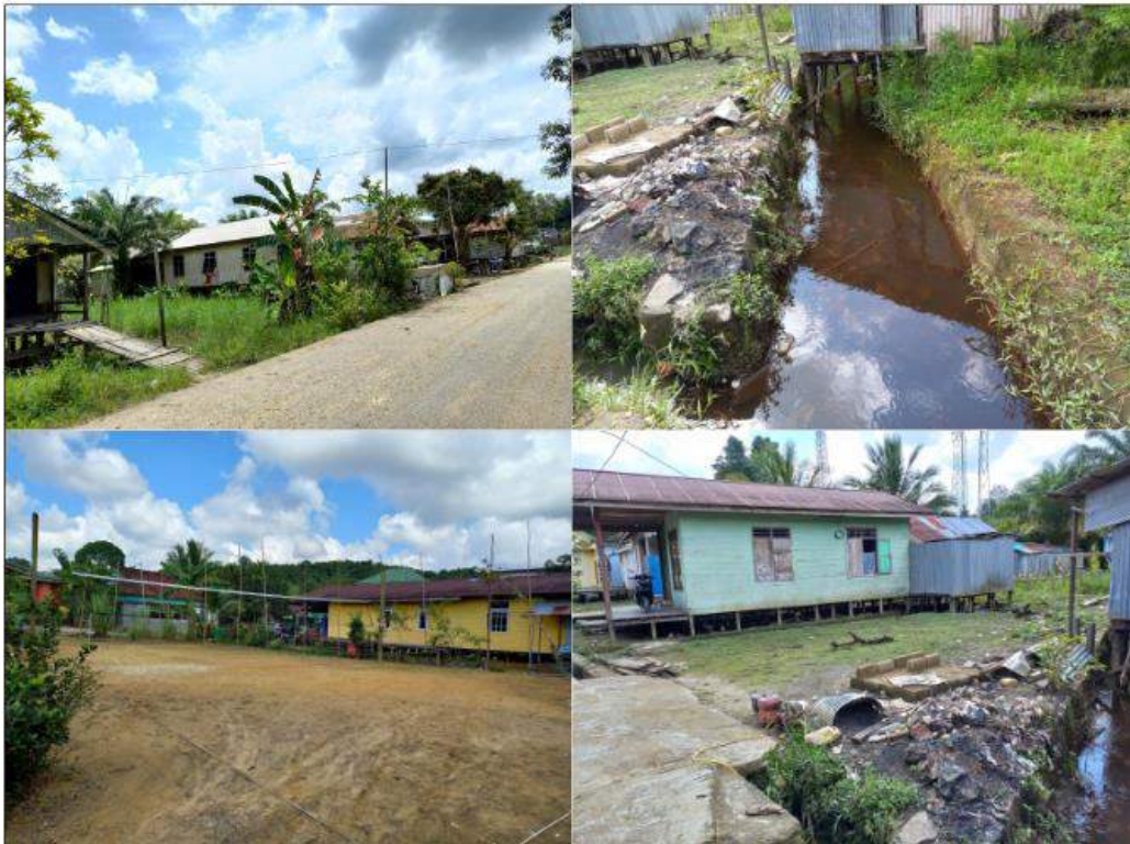
Gambar 3. 9 Kondisi Kekumuhan RT 16 Kelurahan Long Kali
