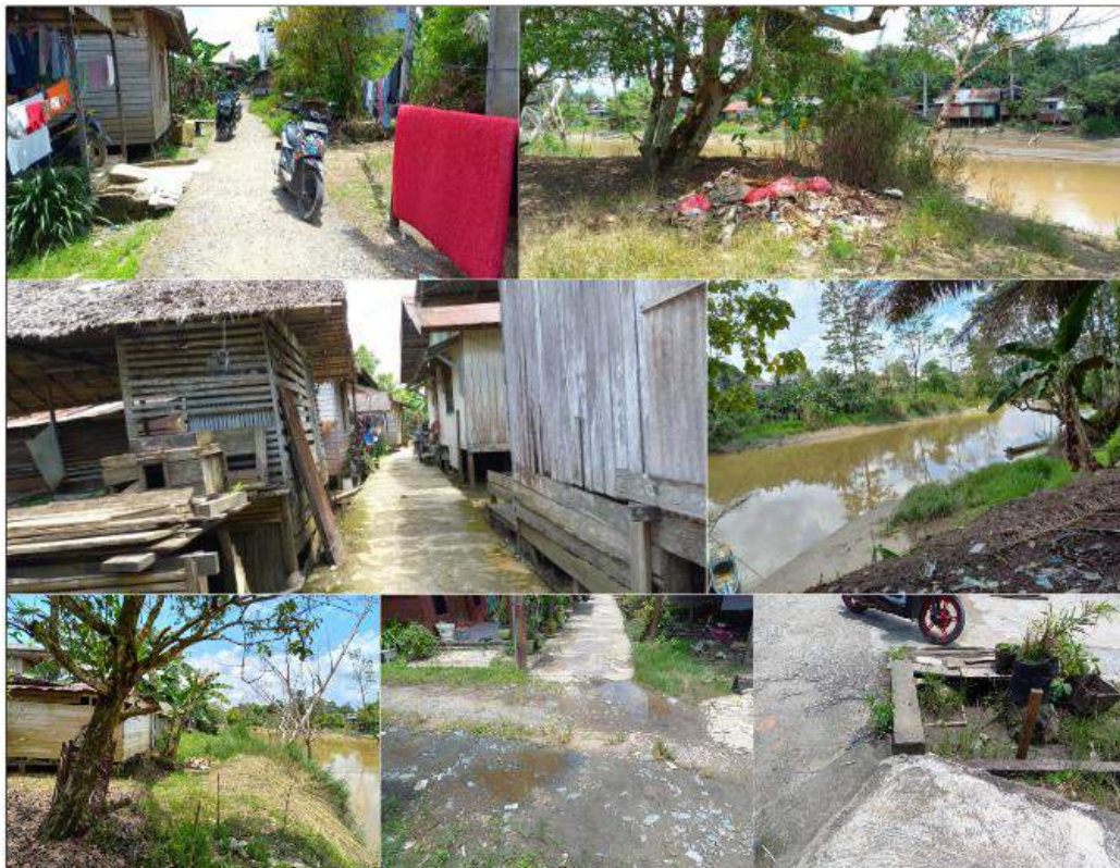
Gambar 3. 6 Kondisi Kekumuhan RT 02 Kelurahan Long Kali
